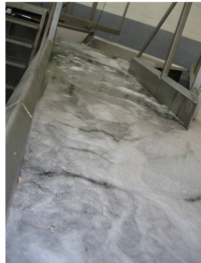
Figur 7. Full filetkjøler sett mot utmatingsenden.
