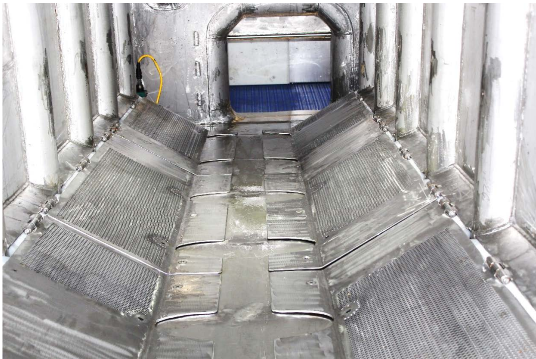
Bilde 3 Inntakstank nr. 4 med skrå bunn. Vannforsyningen i tanken kommer opp på undersiden av den perforerte bunn ut mot sidene av tanken, med cirka 50 cm avstand. Bunnplatene er hengslet ute i sidene og kan slås opp ved behov.
