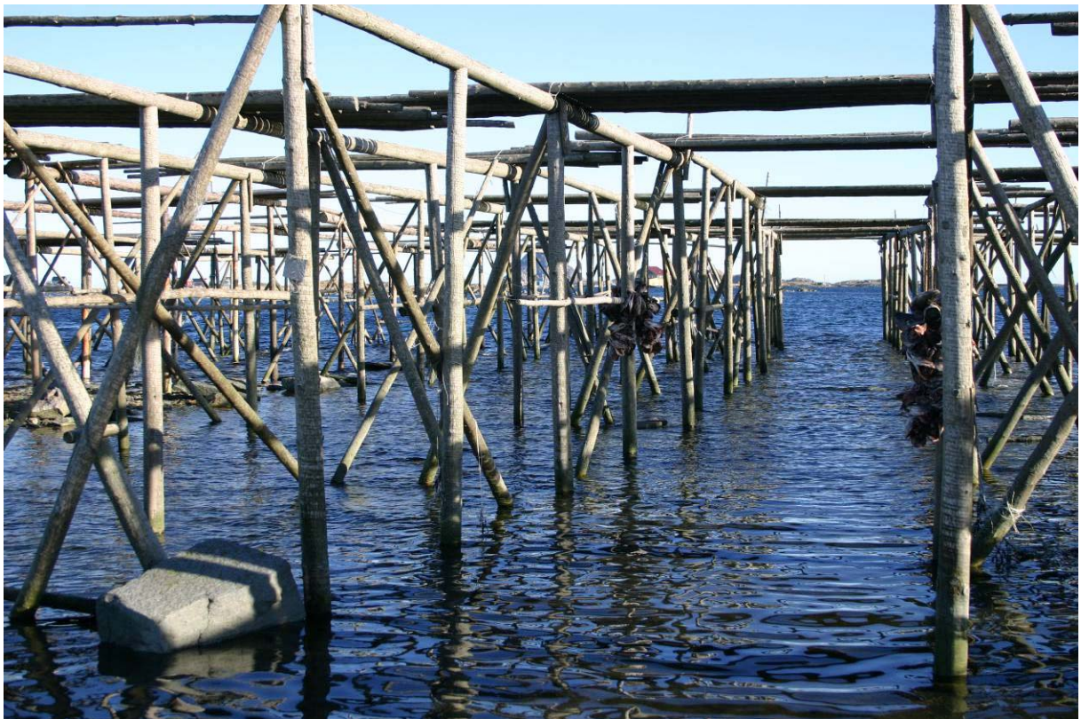
Bilde 10 Hjell plassert slik at den for det meste står i havet.
