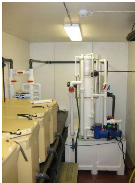
Bilde 7 Mottaksstasjon for kongekrabbe "krabbehotell" i Tromsø basert på 100 % resirkulering (RAS).
