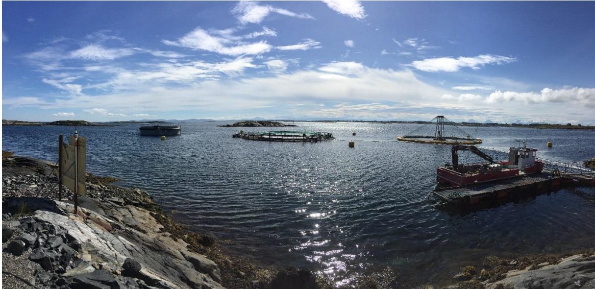
Figur 6 Gullklakken, Smøla, hvor ulike konsept av semi-lukkede anlegg har blitt testet; betongtanken Salmon Home #1 (til venstre i bildet), det presenningsbaserte fleksible anlegget Flexibag (i midten) og den glassfiberforsterka plastiktanken AgriMarine (til høyre). Foto, Jelena Kolarevic.
